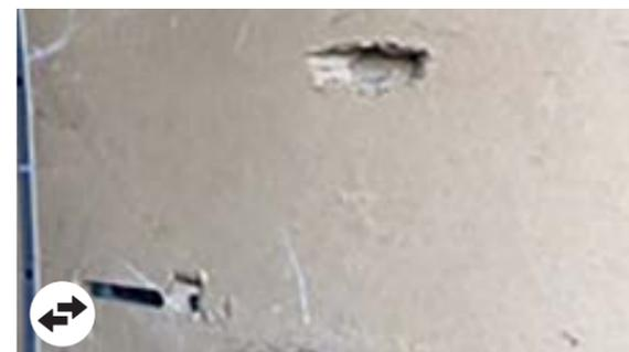
Protecciones internas de madera: Impactos  $> 2$ cm, falta el panel o está roto (excluyendo los paneles superiores de la puerta)
