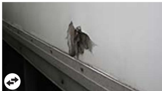
Paneles laterales de madera: Soporte de madera deteriorado  $\geq$  20 cm
