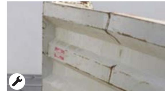
Deformaciones en el conducto con un tiempo de reparación  $>$  1 h que merece la pena de reparar
